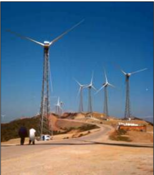
Parc éolien de Koudia Al Baïda (Maroc) : 84 éoliennes de 600 kilowatts chacune.
